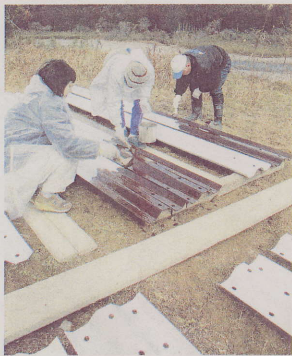
ガードレールの裏面を茶色のペンキで塗装する (13日、新宮市熊野川町で)
